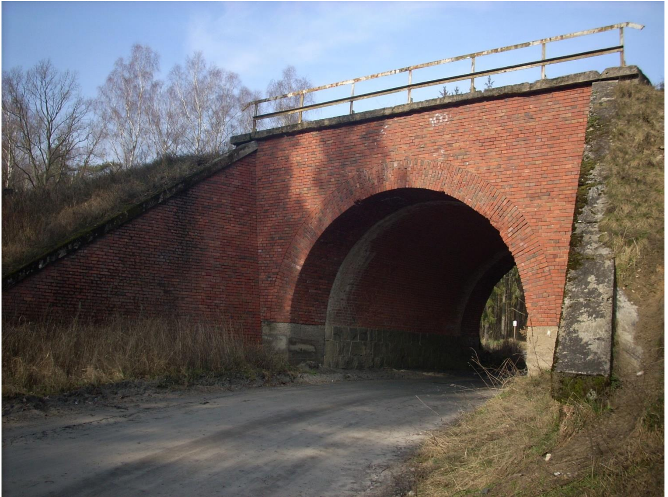
Ilustracja 1. Kolejowy obiekt inżynierski w km 28,310 linii kolejowej nr 203
