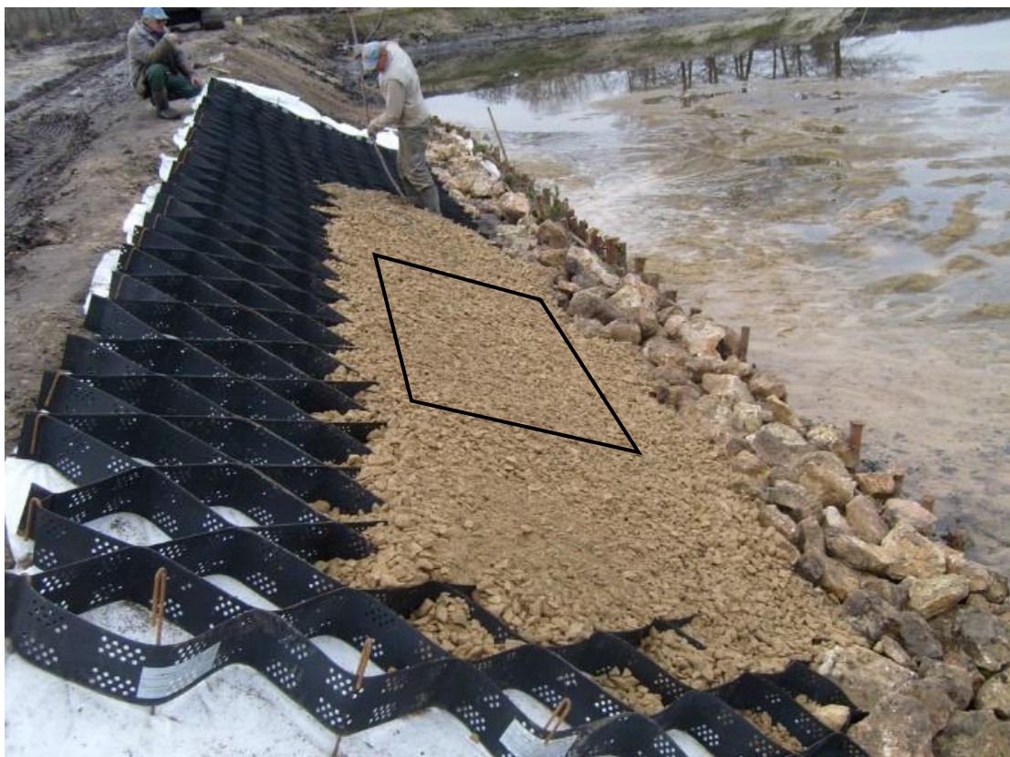
Ilustracja 1. Brzeg stawu z zaznaczonym fragmentem umocnienia geokrąta do wykonania
